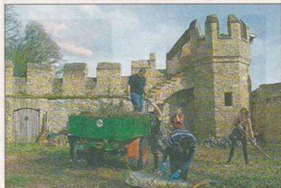
Mit den Aufräumarbeiten ist der erste Schritt getan.
